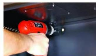
Colgar el armario y asegurar por el interior con el tornillo de fijación de seguridad.
